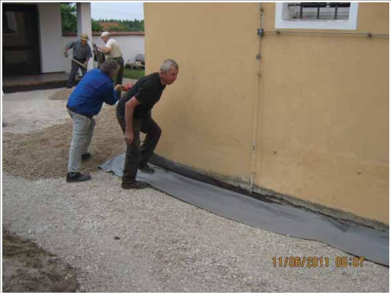
Schutz der neu verlegten Drainage mit Vlies
